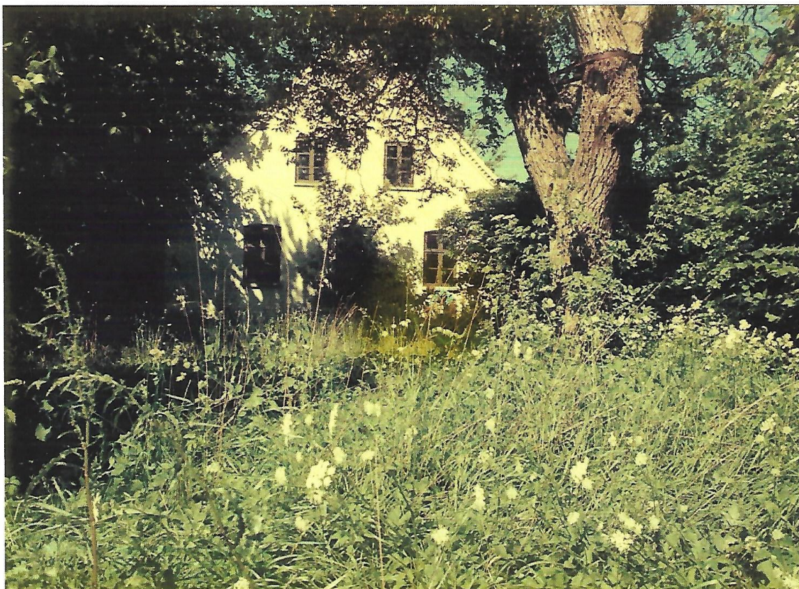
Som et andet Torneroseslot skulle Bakkegården 1988 først frilægges, inden aktiviteterne kunne begynde
