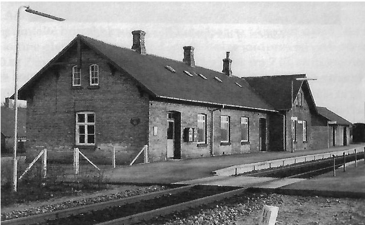
Højby Station få år før den blev nedrevet (27. – 28. juni 2002)
