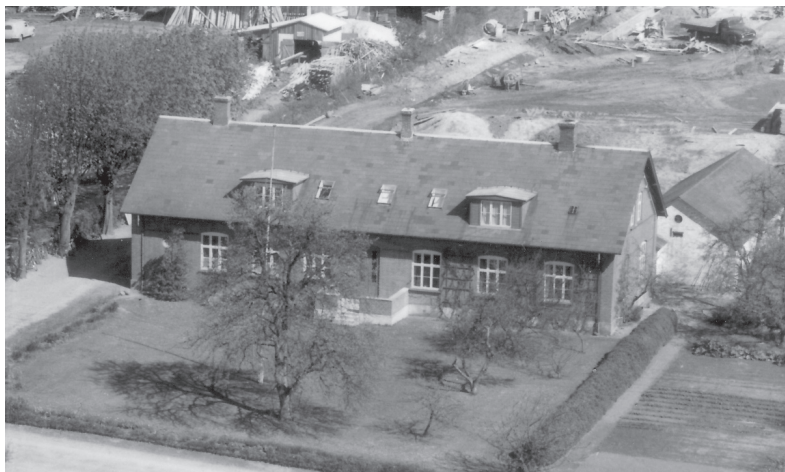
Den gamle Højby Skole fra 1895. Luftfoto af Sylvest Jensen 1958. Arkivet har siden 1984 haft til huse på 1. sal i den gamle skole.
