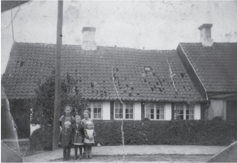
Nr. Lyndelse Vej 9 ca. 1920 som bygningen så ud da den endnu var smedje og bolig
